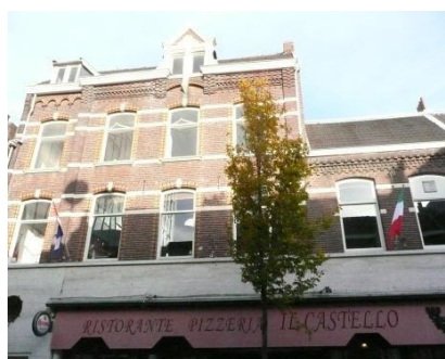
2) De gevel lijkt uit 3 panden te bestaan
