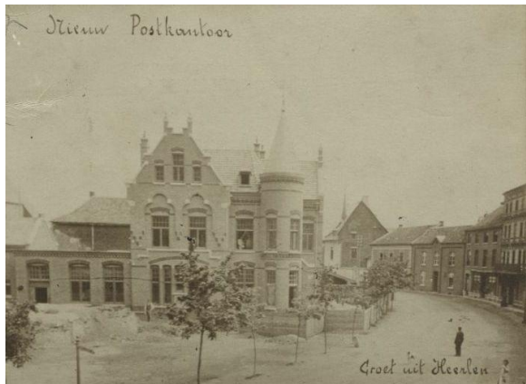
1902 postkantoor in aanbouw
