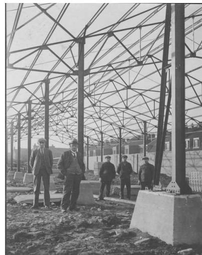
bouw loods Willemstraat
