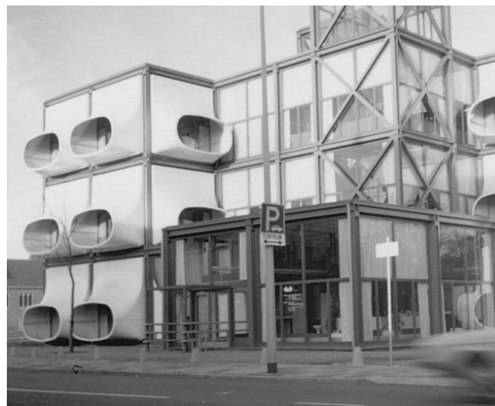
Ook dit markant gebouw is al verleden tijd
